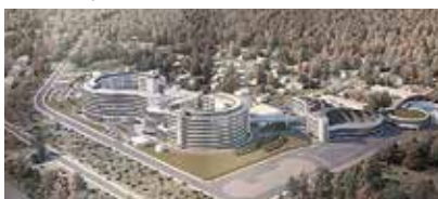
Строится новое здание РНХИ
